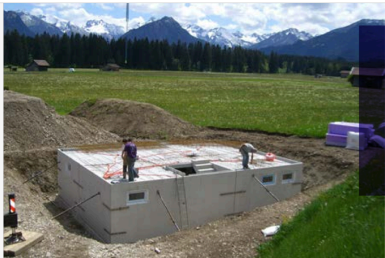
Der Kellerbau dauert nur rund zwei Wochen bis zur Fertigstellung.
