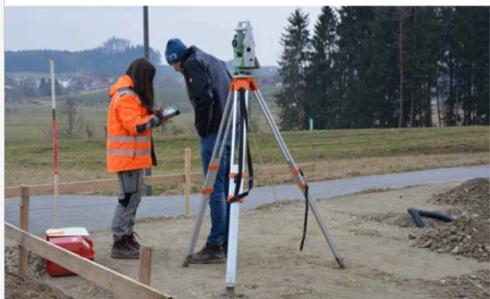
Passgenau für das Grundstück: Vermessungsarbeiten vor Beginn.
